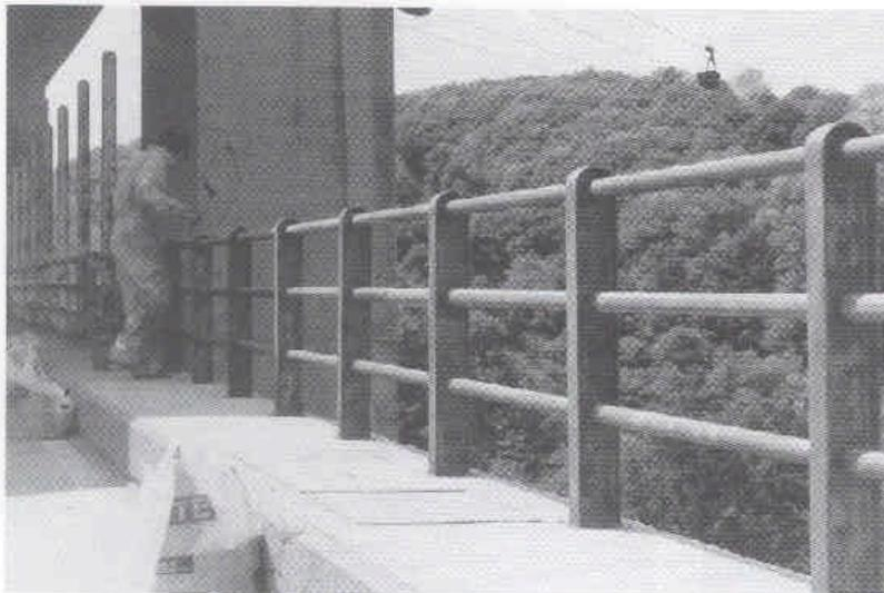
Fig. 7 - "Stripe - coat" con primer epossipoliamicco tipo "surface tolerant"
