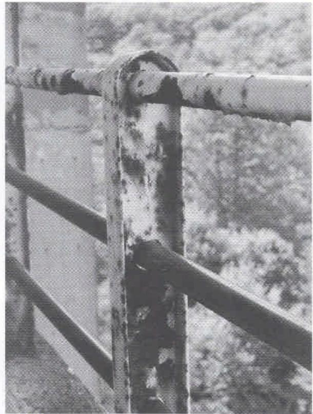
**Fig. 3 - Particolare dei raccordi a mezzo saldatura di tubolari nuovi con strutture preesistenti**
